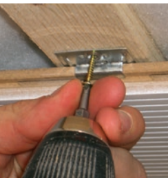
Befestigung mit Montagekrallen
